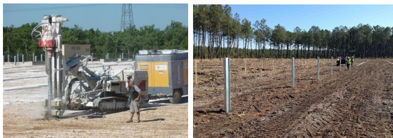
Illustration 5 - Ancrage au sol par pieux battus
